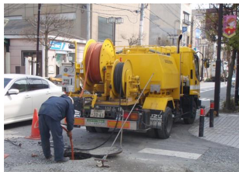
写真 3-1 高圧洗浄車清掃状況
