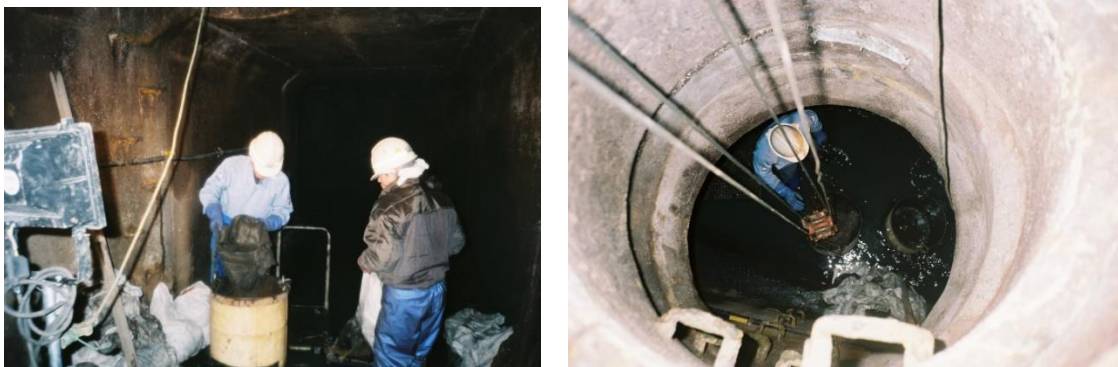
写真 3-10 人力清掃の作業状況
