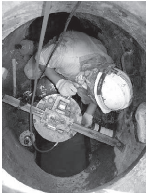
写真-2 消散弁の施工状況
