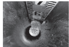
ドレーン設置
