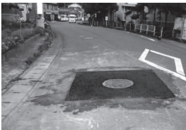
写真-3 ハットリング設置完了
