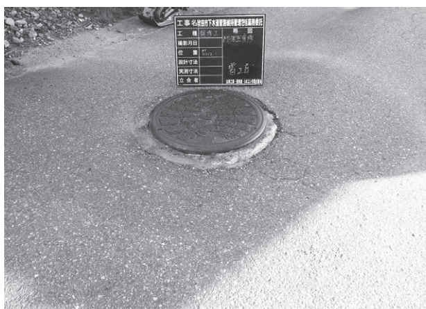
写真－7 マンホール周囲の路盤破損補修状況
