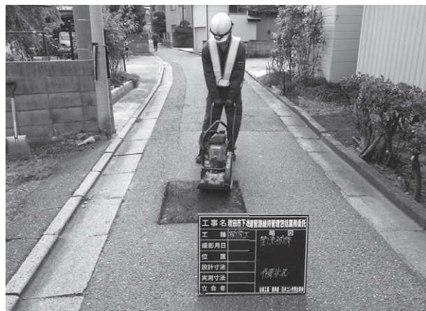
写真－6 道路陥没の補修状況
