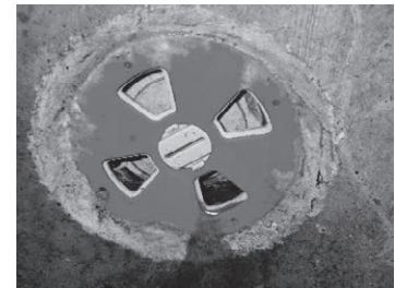
写真-3 設置時 (左) と開放後 (右) の消散弁
