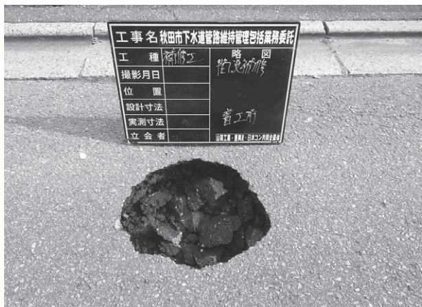
写真－6 道路陥没の補修状況
