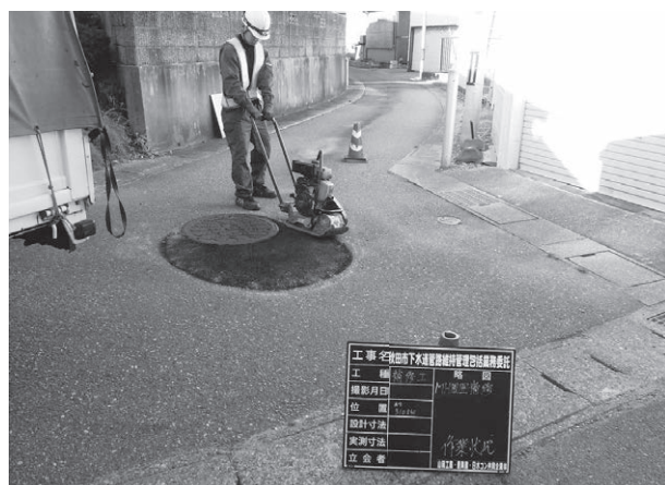
写真－7 マンホール周囲の路盤破損補修状況
