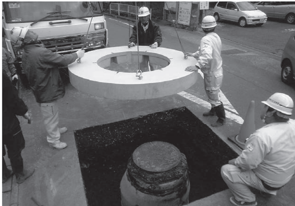
写真-2 ハットリング設置状況
