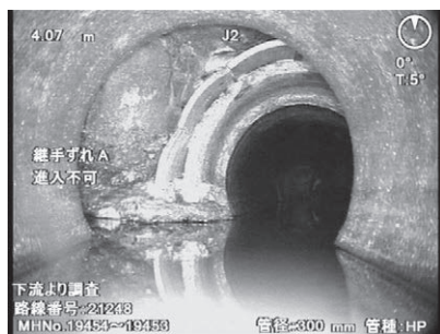
継手のずれ
