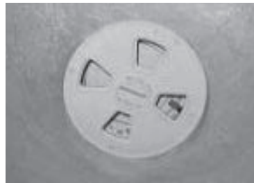
写真-3 設置時 (左) と開放後 (右) の消散弁
