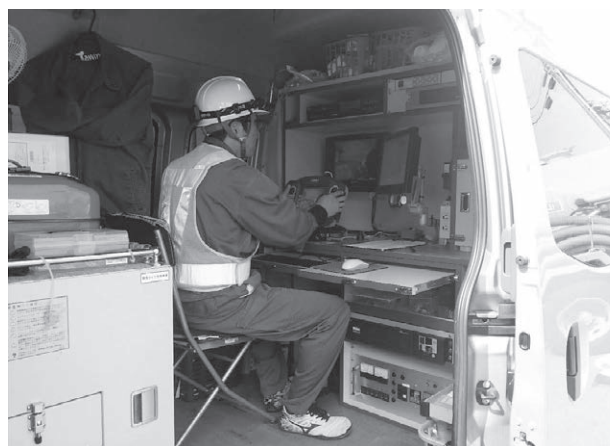
写真-4 管内テレビカメラ調査状況
