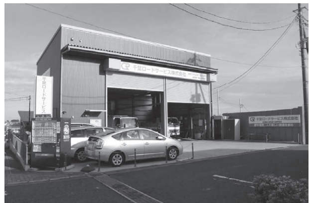
新社屋に自動車整備施設を設けた市川営業所
