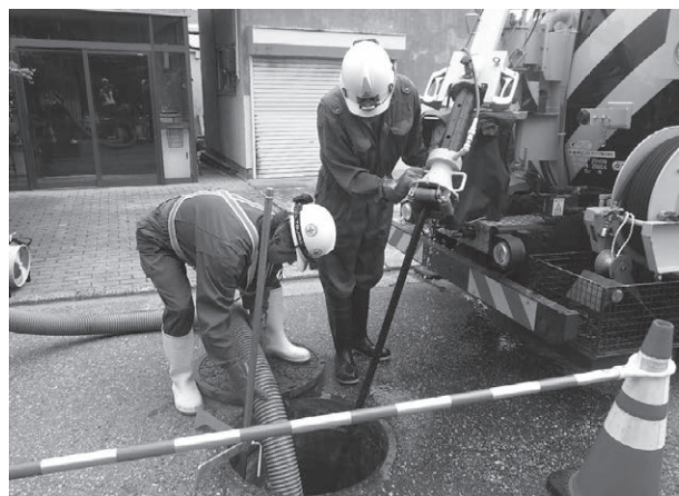
写真-3 管路内の洗浄・吸引作業状況
