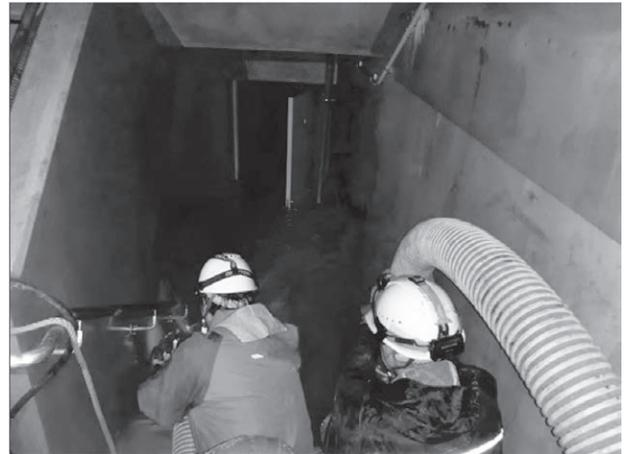
写真2 令和4年の埼玉県内の豪雨被害、中継ポンプ場に溜まった雨水を吸引
