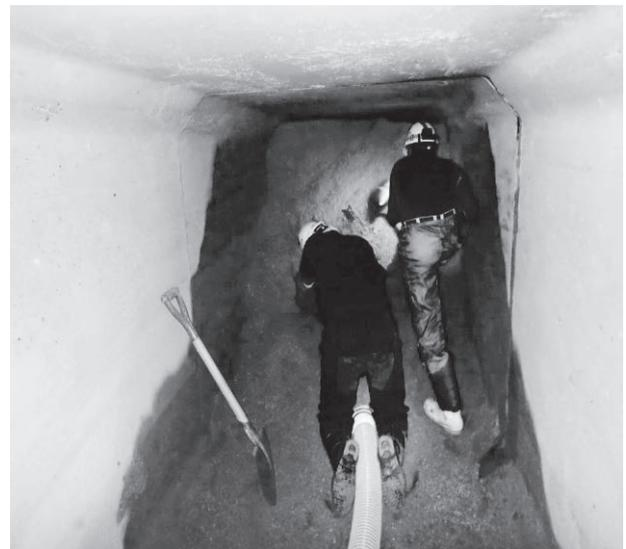
写真3 平成30年7月豪雨時の大口径雨水管土砂除去状況(広島市)
