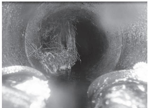
写真1 管内ドローンによる不具合発見例
