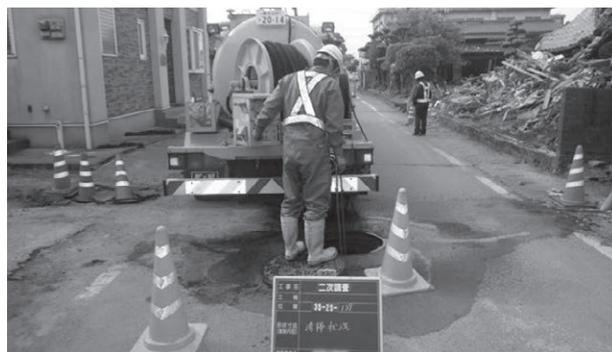
写真2 熊本市内での管内清掃作業
