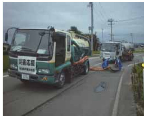
写真 7.2. (1) 応急復旧の状況（吸引車による下水搬送）
