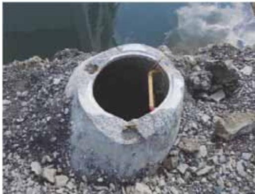
写真 1.5. (2) 津波によるマンホールの破損状況（宮城県女川町、岩手県大船渡市）
