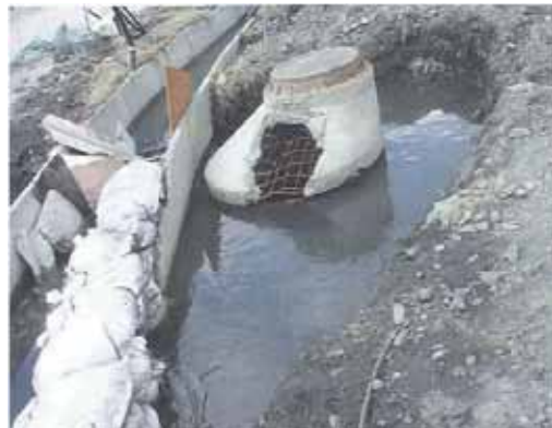
写真 1.5. (2) 津波によるマンホールの破損状況（宮城県女川町、岩手県大船渡市）
