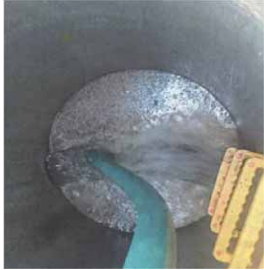
写真 7. 2. (4) 吸引汚水のマンホールでの排水
