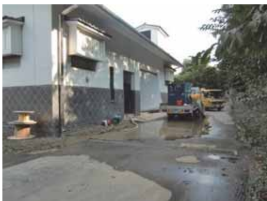
写真 1.6. (1) 平成 27 年 9 月関東・東北豪雨による中継ポンプ場の被災と污水吸引作業（茨城県下妻市）
