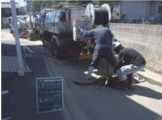
写真 1. 6. (3) 平成 26 年広島市土砂災害における下水道管路施設の被災状況と管内堆積土砂の吸引作業
