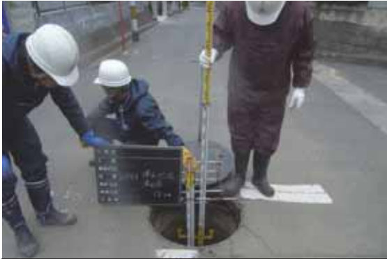
黒板とスタッフ等を当てて全景写真を撮影
