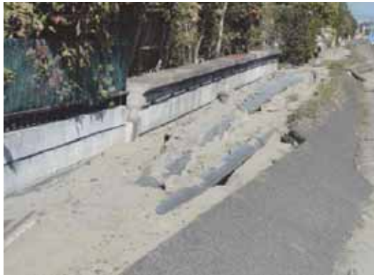
写真 1.5. (1) 液状化による被害の状況
