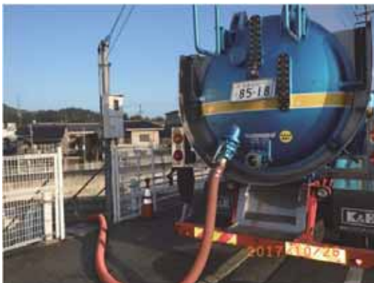
写真 7.2. (2) マンホールポンプにおける吸引作業
