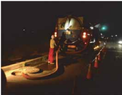
写真 7.2. (1) 応急復旧の状況（吸引車による下水搬送）
