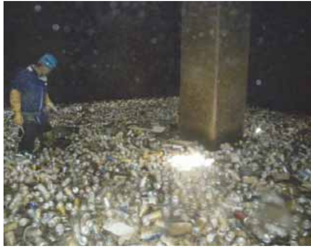
写真 1.5. (3) 津波により流出した多量の飲料缶（宮城県内雨水幹線）
