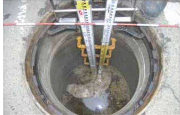
ピンポールを蓋受枠に水平に置きスタッフ2本を挿入
