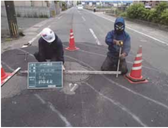
【マンホールと路面の段差】
