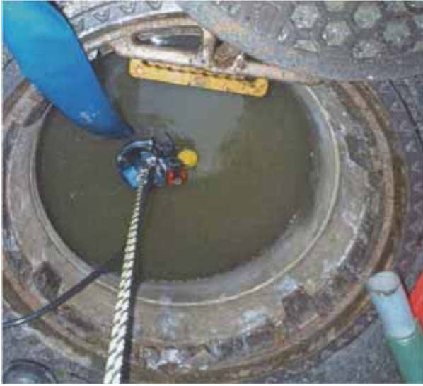
写真 7. 2. (3) 水中ポンプによる吸引
