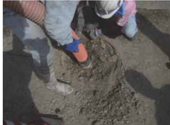
写真 1. 6. (3) 平成 26 年広島市土砂災害における下水道管路施設の被災状況と管内堆積土砂の吸引作業
