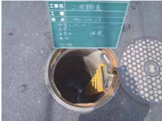
【調整コンクリートの破損】
