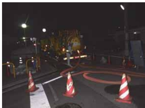
写真 1.6. (2) 平成 29 年台風 21 号による堺市溢水事故の污水搬送作業
