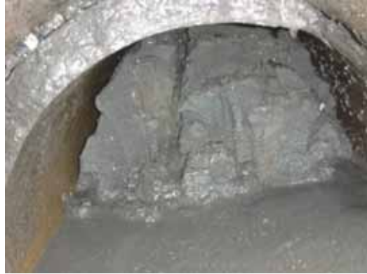
宮城県大河原市における埋戻し土の液状化による地盤沈下(塩ビ管浮上)
