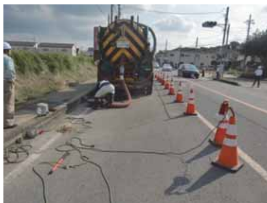
写真 1.6. (1) 平成 27 年 9 月関東・東北豪雨による中継ポンプ場の被災と污水吸引作業（茨城県下妻市）
