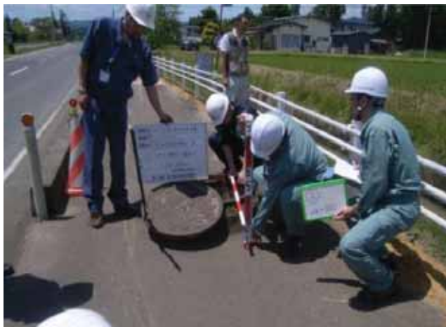
写真 3.5. (1) 緊急調査（マンホール浮上）
