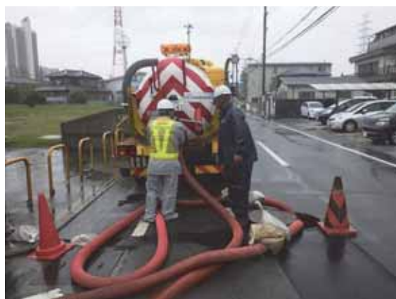
写真 1.6. (2) 平成 29 年台風 21 号による堺市溢水事故の污水搬送作業
