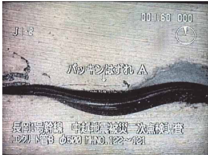
写真 8.4. (1) パッキン外れ
