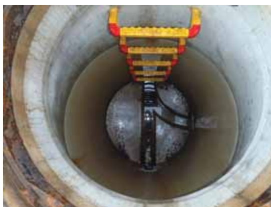
写真 8.5. (1) マンホール調査の基本写真3点
