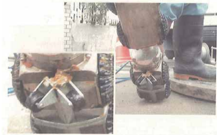
写真 8.6. (4) テレビカメラ調査の工夫事例
