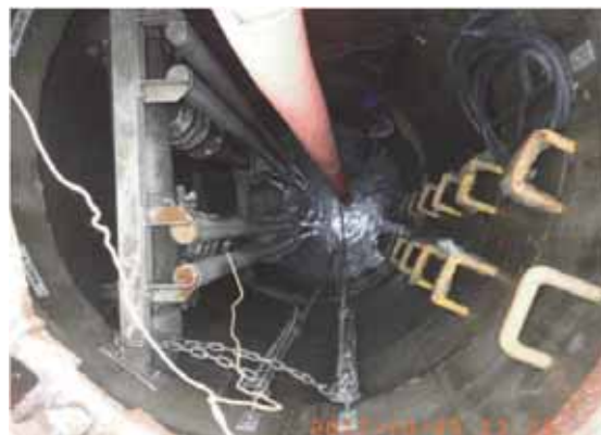
写真 7.2. (2) マンホールポンプにおける吸引作業
