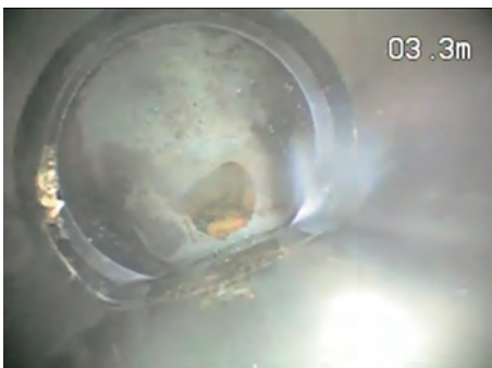
写真1 取付管破損の様子
