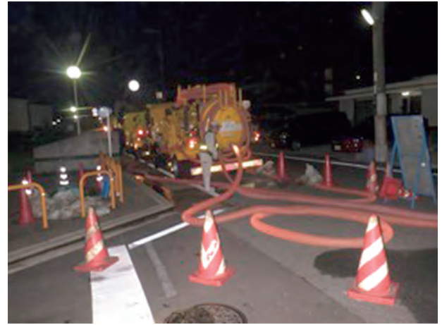
写真2 今池緊急汚水移送作業応援業者による吸引実施
