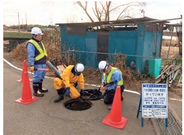
写真1 現地での点検風景（人孔調査）
