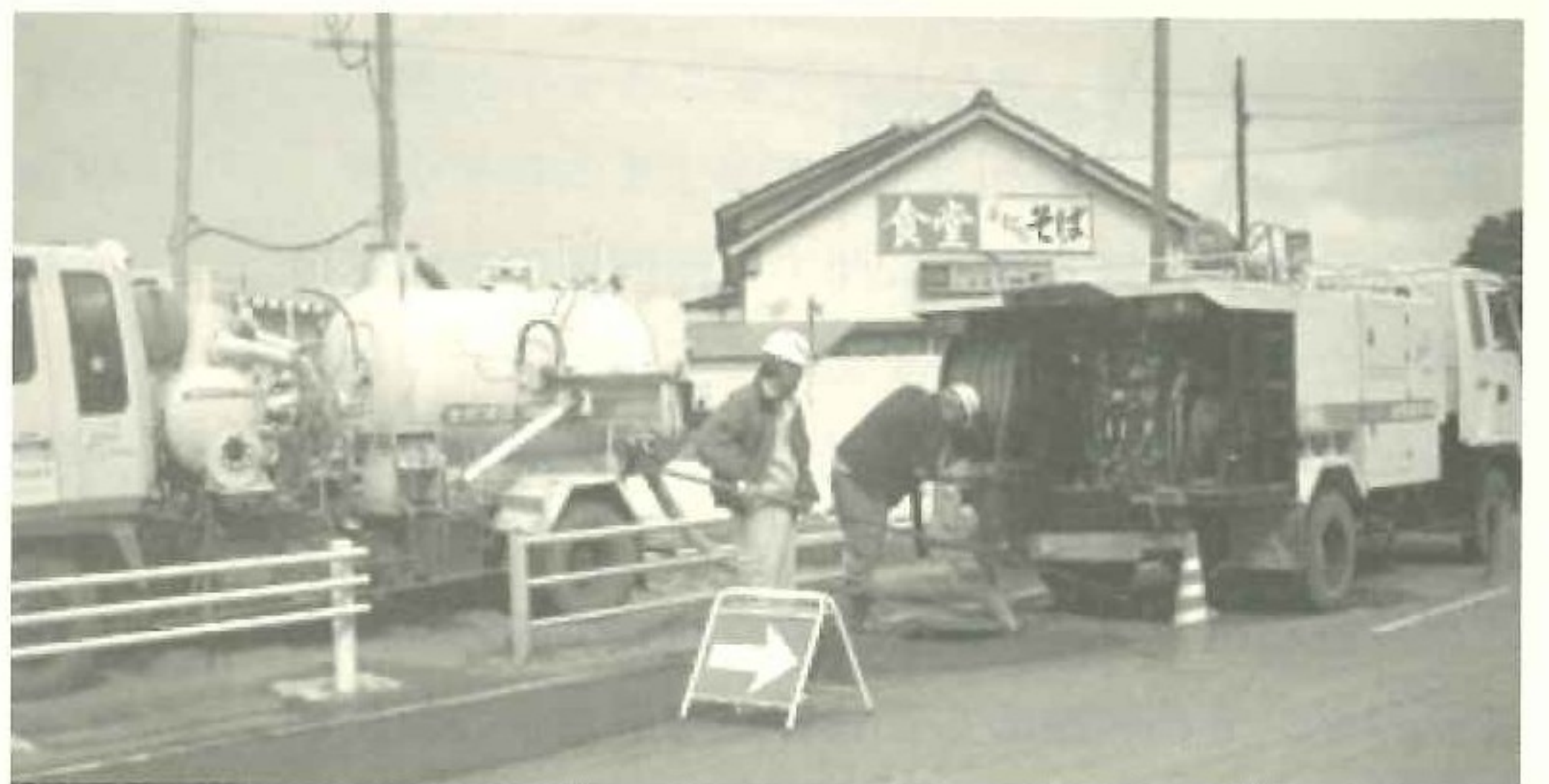
写真-7 TVカメラによる調査の状況（志賀町）
