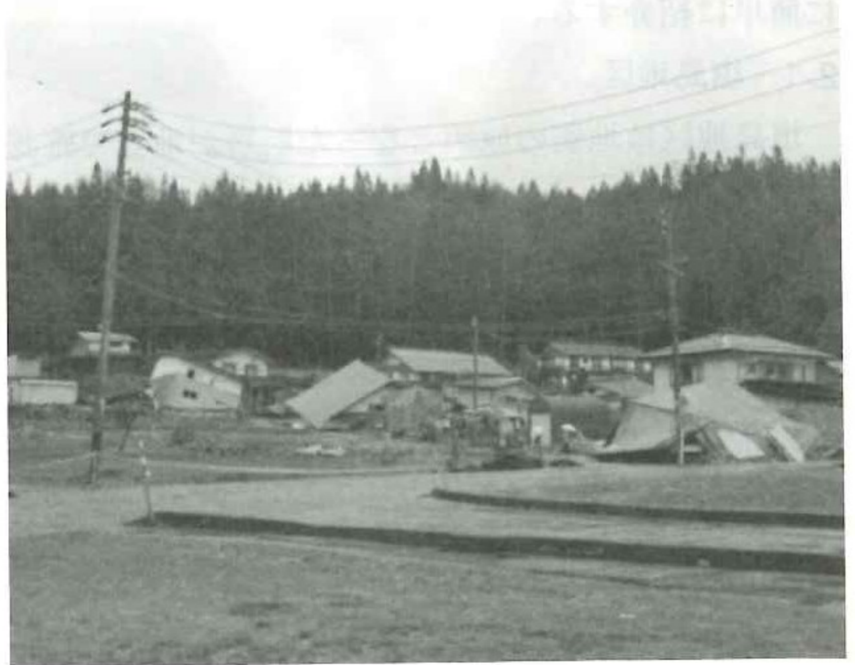
写真-8 家屋の倒壊
